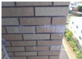
エフロとは、目地などから雨水などがコンクリート内に浸入し、モルタル中の水酸化カルシウムと混じってひび割れなどが発生し、それが空気中の炭酸ガスと反応して白く盛り上がったように固まる現象。白華とも呼ばれる。
