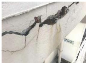
コンクリート内部の鉄筋の腐食膨張により表面コンクリートが押し出された状態。
