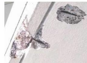
爆裂が進行しコンクリート剥離してしまい、コンクリート内部の腐食した鉄筋が露出した状態にまでなったもの。
